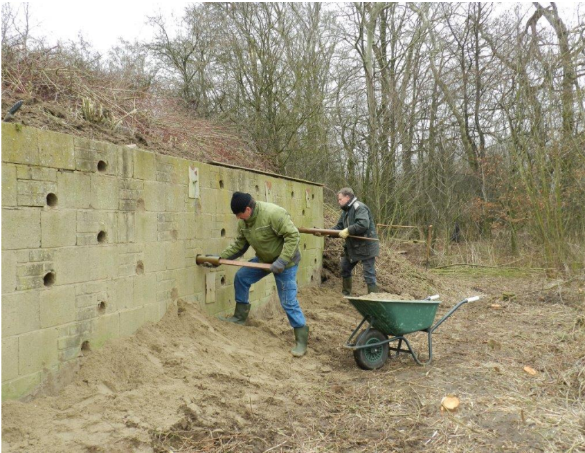
Het opvullen van de gaten met vers zand
